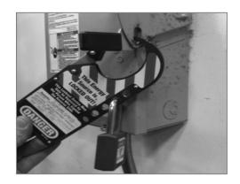
只有在电源被关闭、挂牌及上锁了的情况下 才可使用设备。操作手册中陈述的由电工或 其他有资格的人员进行操作的有限例外情况除 外。 不遵守该规章可能会导致电气伤害、严 重身体伤害,和/或触电致死的情况
